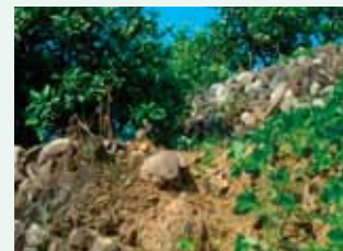
イノシシによる石垣の崩落被害
